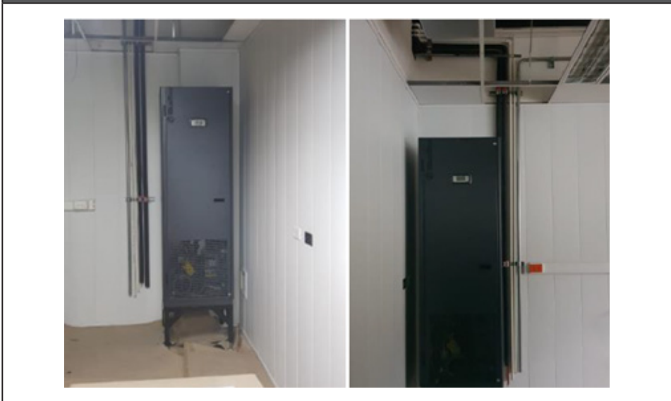
Figura 1. Instalación de dos equipos de ajuste fino de condiciones ambientales tipo BlueBox , modelo Datatech+EDA 7.1M, en el laboratorio de masa
