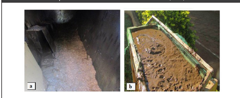
Figura 2: (a) Lodo no interior dos decantadores e (b) Caixote de madeira com furos laterais para adensamento do lodo. Fonte: O autor (2019)
